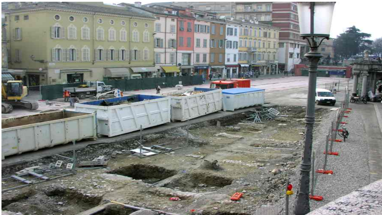
La demolizione dei box nel gennaio-febbraio 2007
